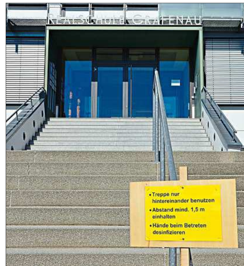
Abstand halten: An der Realschule Grafenau wird daraufhin bereits vor dem Eingang hingewiesen. – Foto: Realschule Grafenau
