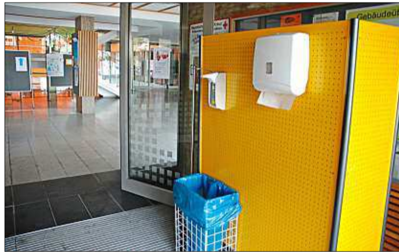
An den Eingängen werden – wie hier am Gymnasium Freyung – Desinfektionsspender aufgestellt.
